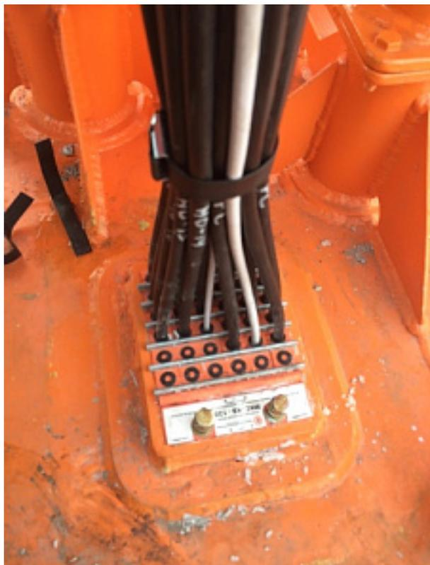
Наименование оборудования: [Взрывозащищённая универсальная модульная кабельная проходка марки МКС \(кабельные вводы\) типа KV](#)
